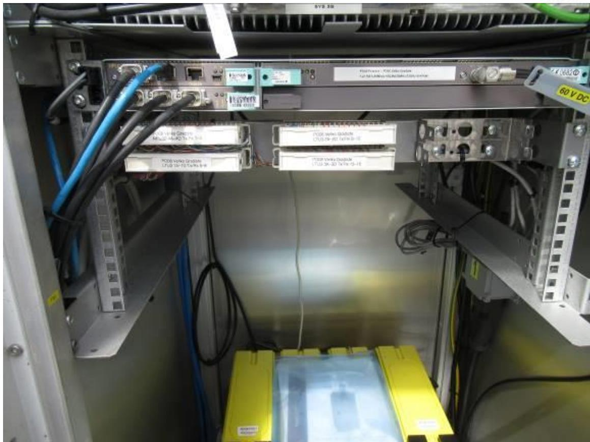
*Oprema za prenos u Eltek kabinetu - DDF + AMM2p IDU jedinica*
